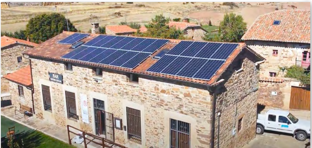
Castilfrío de la Sierra (Soria), acoge el proyecto Hacendera solar, una comunidad energética que cubrirá parte de la demanda eléctrica del municipio y ayudará a reducir las emisiones de carbono y el gasto energético de la localidad y de sus habitantes. Promovida por el Grupo Red Eléctrica, la cooperativa Megara Energía, el ayuntamiento y Caja Rural de Soria.
