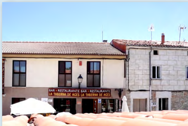
La cubierta del Albergue Municipal de peregrinos (a la izquierda de la imagen) alojará la primera instalación fotovoltaica de Agés, que abastecerá a edificios municipales, alumbrado y doce viviendas particulares de la localidad.
