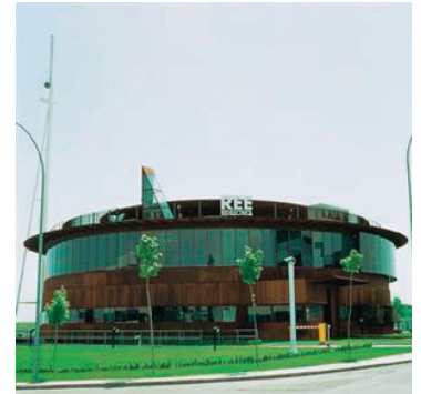
Red Eléctrica Corporate School (ECRE) in Tres Cantos (Madrid)
