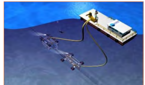
Equipo que prepara la zanja para el cable en zonas poco profundas.
