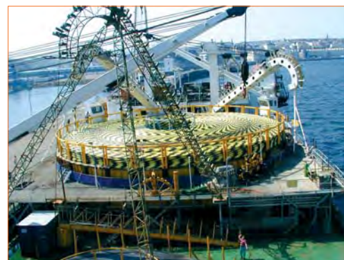
Cable submarino de transporte de energía en la cubierta del Giulio Verne .
