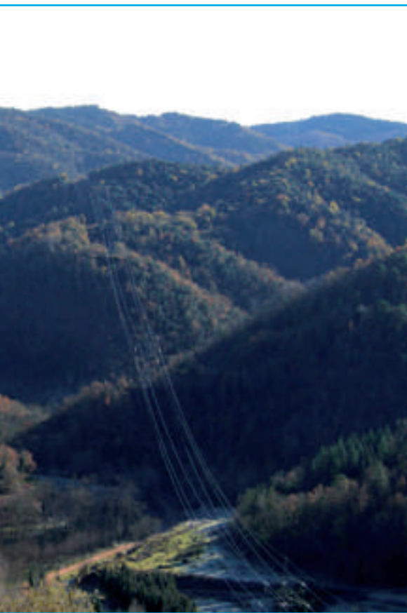
Ligne de 400 kV Sentmenat-Bescanó, à son passage par le parc naturel de Las Guillerías.
