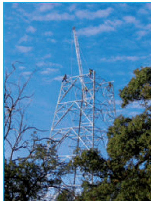
Montage d'un des pylônes de la ligne Sentmenat-Bescanó.
