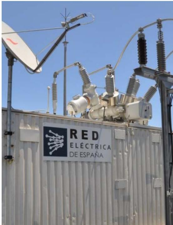
En concreto, el sistema instalado en la subestación de Mácher 66 kilovoltios (kV), en el municipio de Tías (Lanzarote, islas Canarias), podría absorber energía eléctrica de la red con una potencia máxima de 1,65 megavatios (MW) durante aproximadamente 12 segundos, aportando un total de unos 18 megavatios por segundo (MWs) de energía, según la programación del equipo. Este volante de inercia ha sido desarrollado por ABB.
