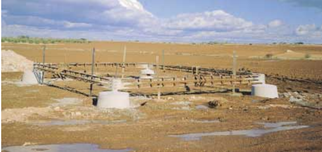
Secuencia de cimentación de apoyo (II)
