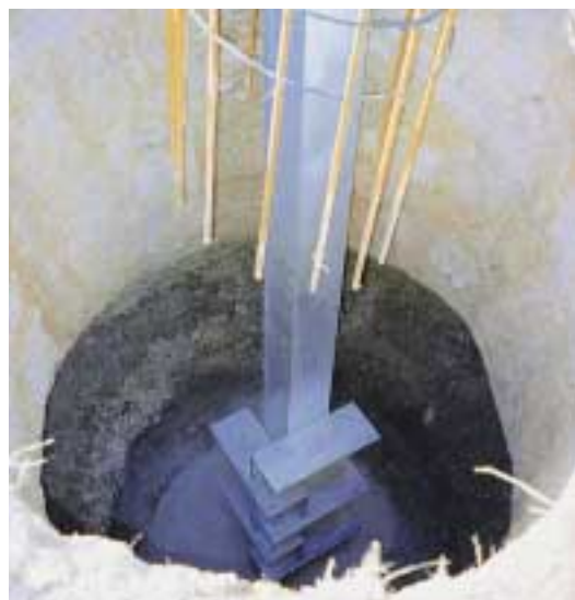
Secuencia de cimentación de apoyo (I)
