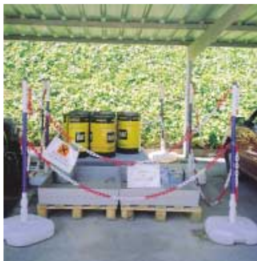
Almacenamiento de residuos: área de almacenamiento de residuos peligrosos cubierta
