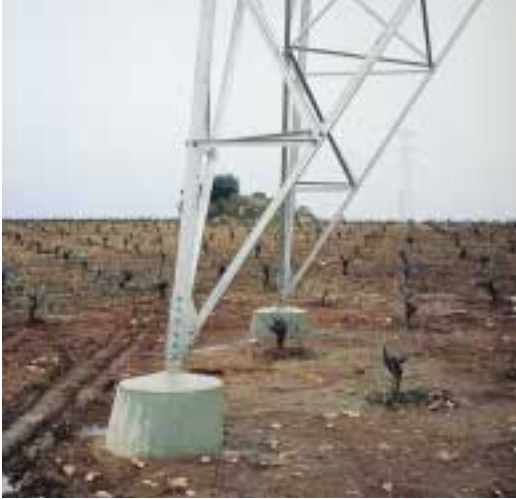
Secuencia de cimentación de apoyo (III)
