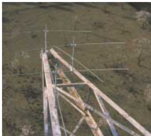
Modelo de utilidad: dispositivo disuasor de nidificación para apoyo de líneas eléctricas
