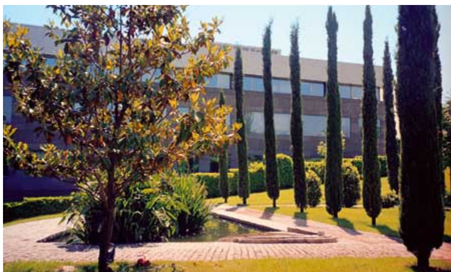
Edificio de la Sede Social en Madrid
