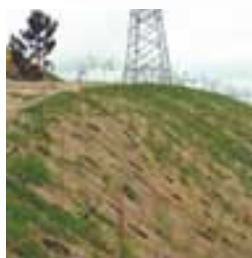
Evolución de la recuperación de un talud de la subestación Boimente.
