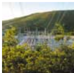
Integración de la Subestación Aparecida en el entorno
