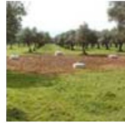
Peanas de un apoyo en la construcción de la línea Balboa-Frontera Portuguesa con la restauración del terreno afectado.
