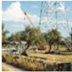
Izado de un apoyo por tramos con una grúa pequeña en la línea Balboa-Frontera Portuguesa.
