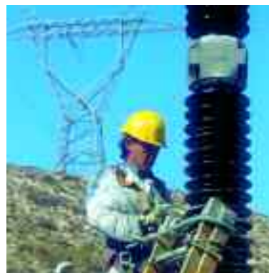
Operario trabajando en un apoyo
