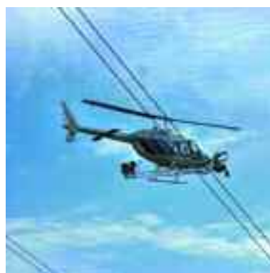
Instalación de salvapajaros en tensión
