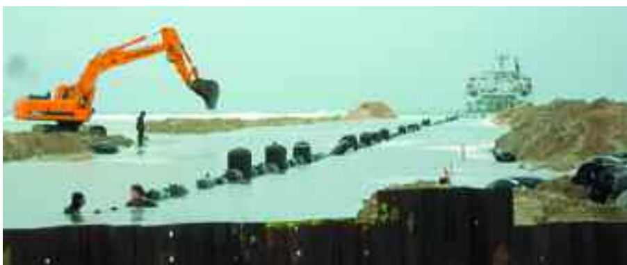
Tendido del 2º cable de la interconexión España-Marruecos en el Parque Natural del Estrecho
