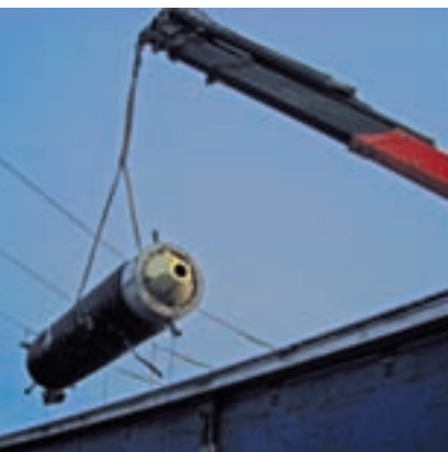
Retirada de equipos con aceite
