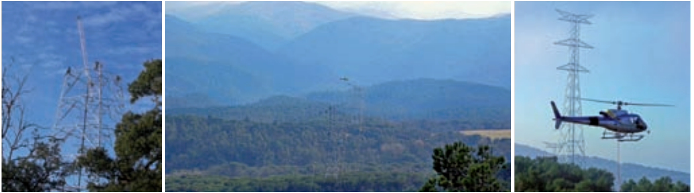
Izado de apoyo con pluma y tendido con helicóptero L/ Sentmenat-Vic-Bescanó.
