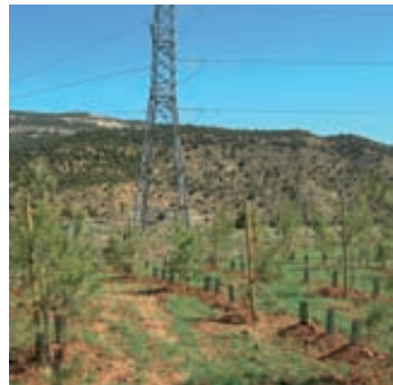
Adecuación paisajística SE Morella
