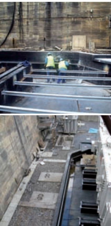
Sistemas de contención. SE Güeñes
