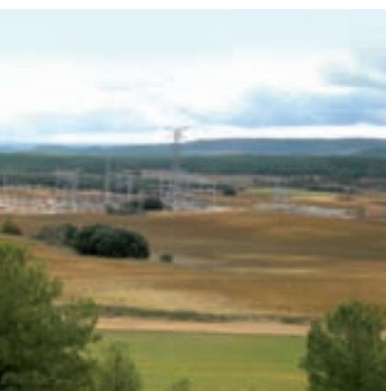
SE Villanueva de los Escuderos en construcción
